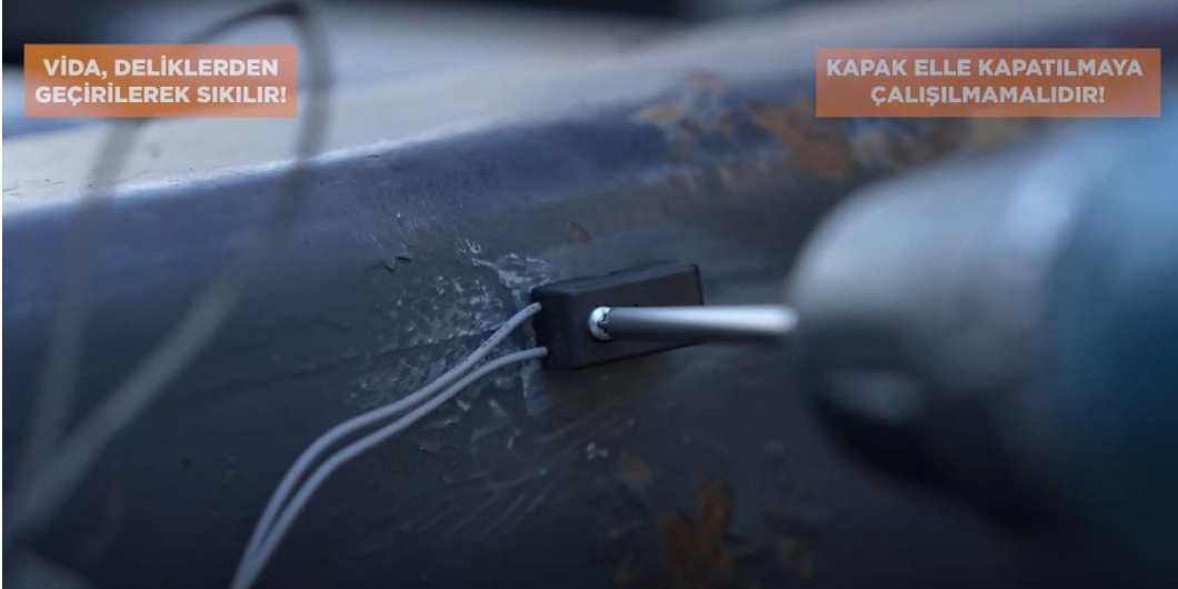
Şekil 9 Tek Taraflı Vida Montajı
