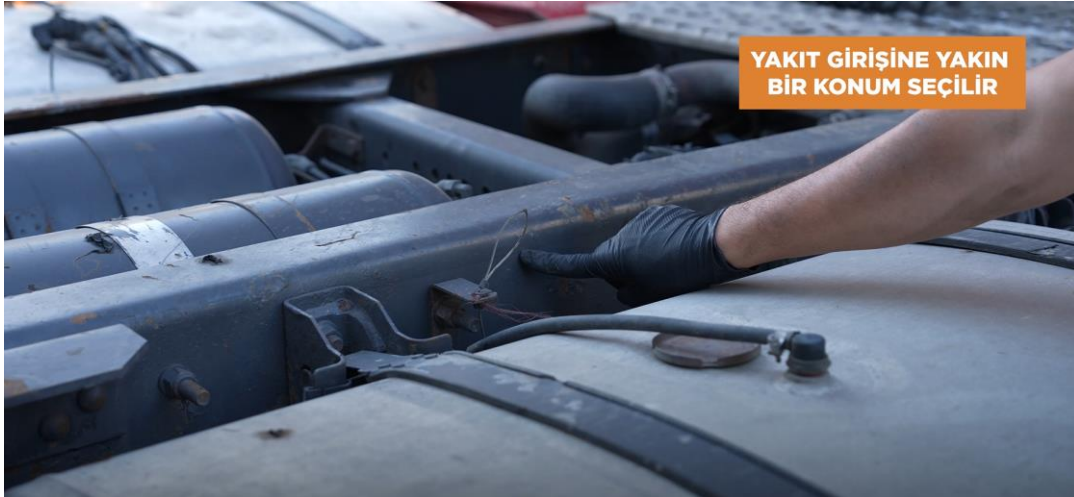
Şekil 3 Çip Montajı Yapılacak Noktanın Belirlenmesi
